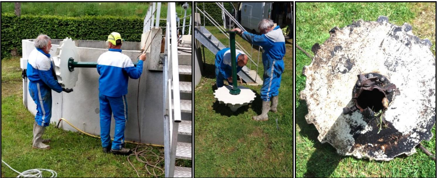
La station a déjà 14 ans et l'arbre d'entraînement de la turbine du bassin d'aération a cédé. Il a fallu compenser le manque d'oxygène par l'injection d'air comprimé 24 h sur 24 h, pendant près d'un mois.
