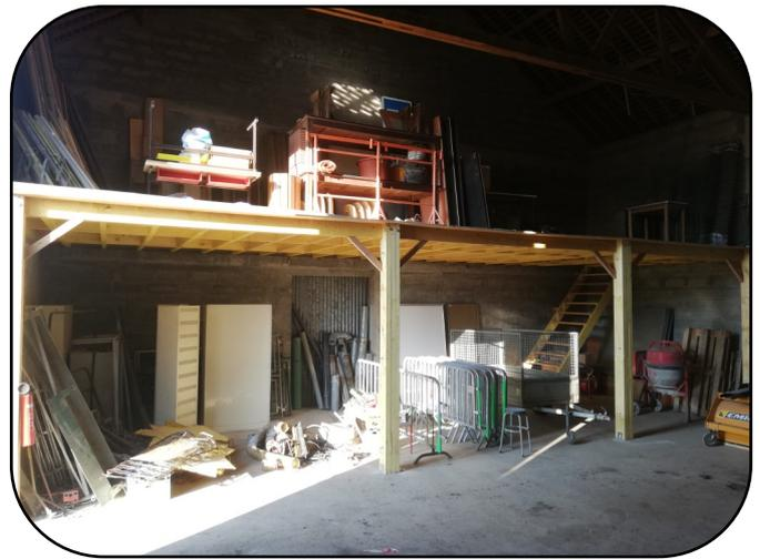
Fabrication d'un plancher pour rangement de
