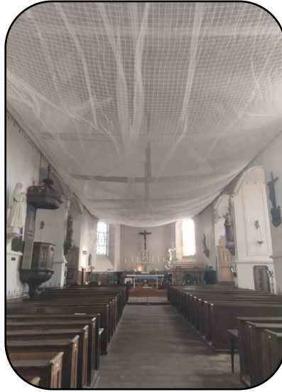
Pose du filet de sécurisation de l'église
