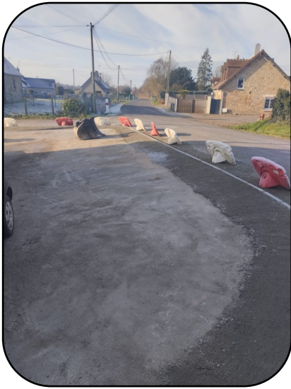
Sécurisation du carrefour de la Chesnaie
