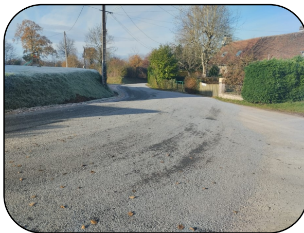
Réfection du virage du village de la Botellerie
